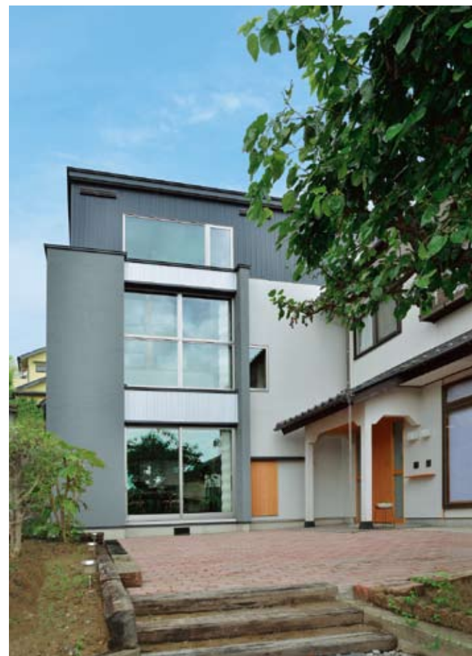
スクエアでモダンな外観は、片流れ屋根ならではの世界。壁の最上部の窓に見える横長のスリットがWB工法独特の換気口。
